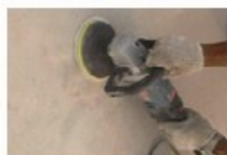
基面打磨处理
